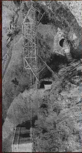
中央本線深沢工事現場(明治34年頃)
