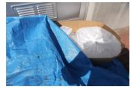
③ 隙間なく段ボール箱を並べ、シートで包み、水の浸入を防ぎます。
