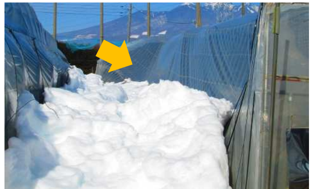
側圧による被害
