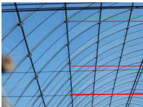
針金を使用した補強例
