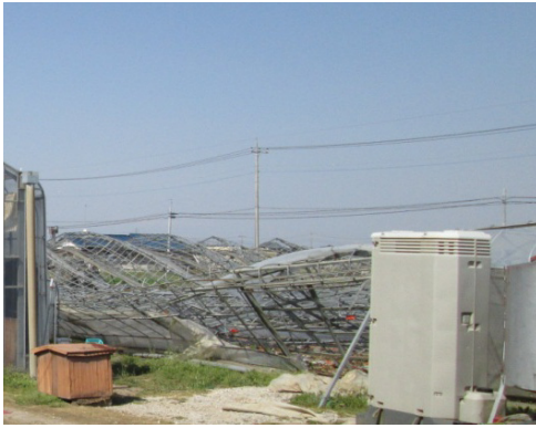
積雪と強風により横倒しに倒壊した事例
