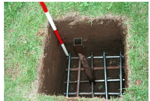
パイプによる基礎部の補強*
