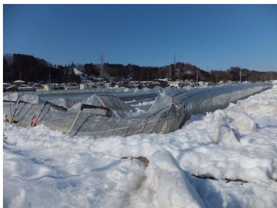
連棟パイプハウスの倒壊
