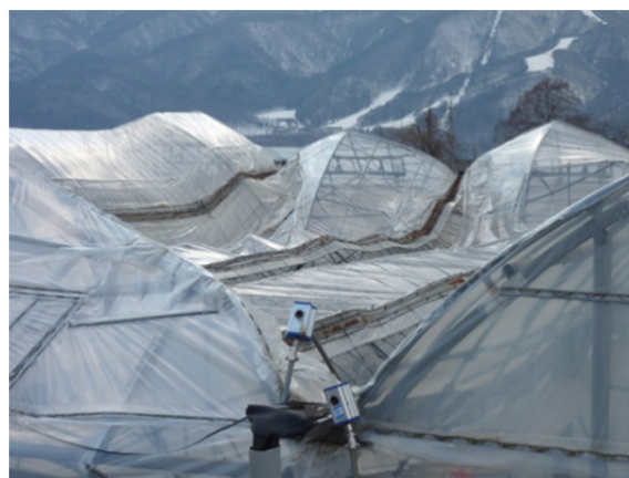
連棟パイプハウスの倒壊
