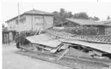
7月16日に震度6を超え発生した、新潟県中越沖地震。写真手前の家屋は地震の威力により押しつぶされた。地震に対して、みなさんの備えはどうか。(写真提供：新潟県)
