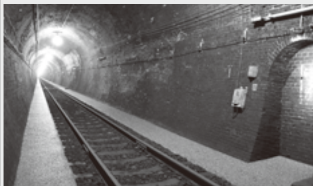
遊歩道でよみがえった「100年トンネル」
