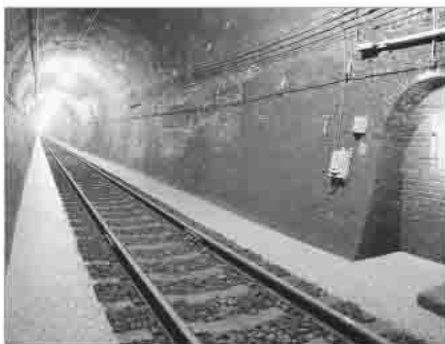
大日影トンネル遊歩道
