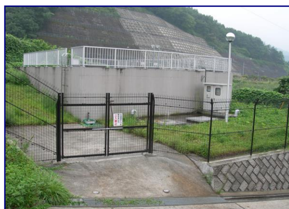
勝沼 岩崎配水池
