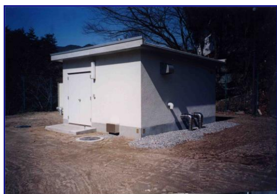
大和 中部配水場
