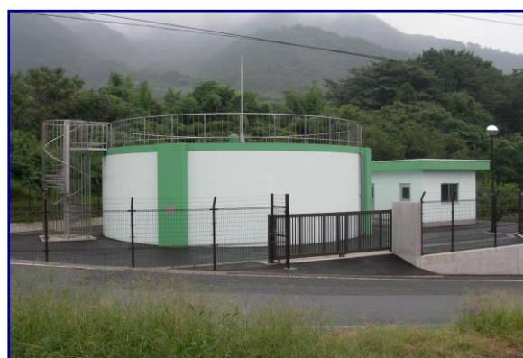
塩山 東部低区配水池
