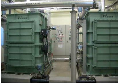
玉宮浄水場膜ろ過設備
