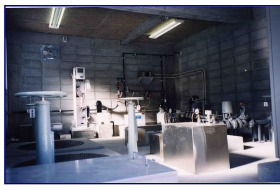
大和 中部配水ポンプ施設
