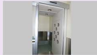
【エアシャワー室】
