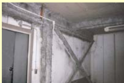
(柱・梁・天井などに吹き付けられたアスベストの例)
