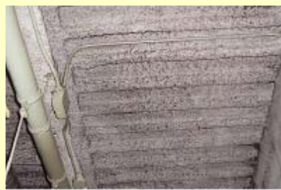
(柱・梁・天井などに吹き付けられたアスベストの例)
