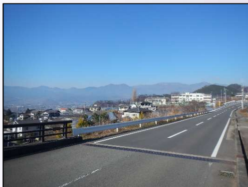
修景予定箇所 (令和2年度実施予定)
