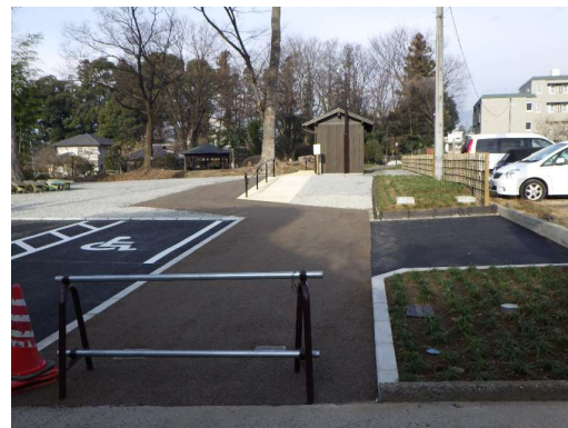
【新設トイレ及び周辺整備】
