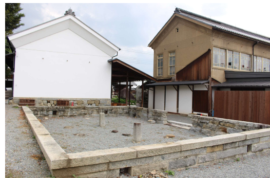
【 東三番蔵解体跡 】
