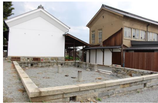
【 東三番蔵解体跡 】
