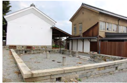
【 東三番蔵解体跡 】
