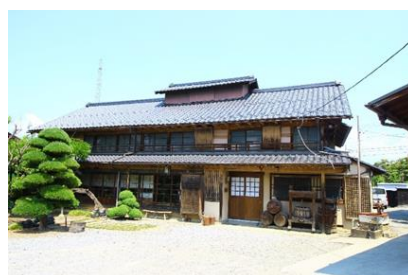
■勝沼氏館跡 東屋 史跡勝沼氏館跡内に設置された東屋を再整備として、屋根葺き替え及び構造補強を実施した。（平成29年度）
