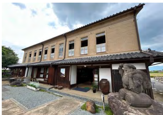
【宮光園主屋 修繕】 実施日：令和6年1月 外壁水切り・瓦面戸漆喰・2階窓廻り修繕
