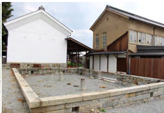
【 東三番蔵解体跡 】
