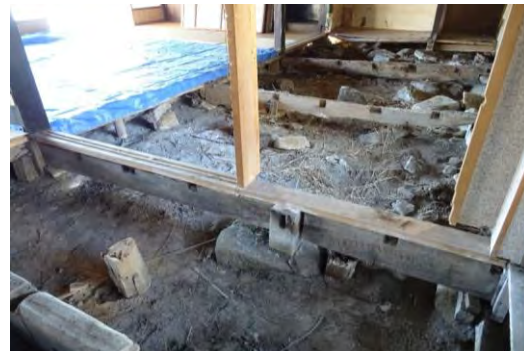
【床掘状況確認・解体調査】
