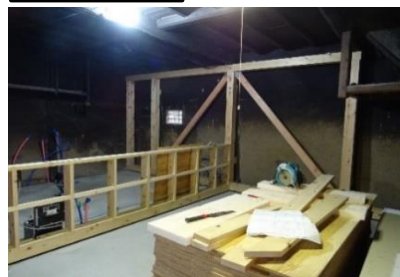
【特定物件の耐震対策】 令和6年度、歴史的建造物(特定物件)1件について、保存のため修理工事を実施する際して、「筋違い補強」をなど耐震対策をした。
