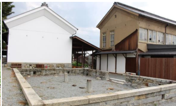
【 東三番蔵解体跡 】
