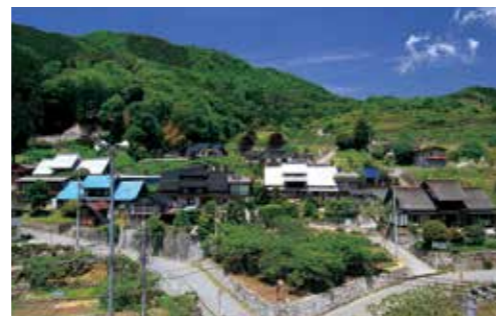
甲州市塩山下小田原上条 重要伝統的建造物群保存地区に選定
