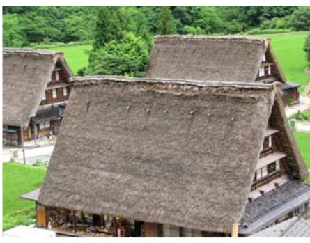
合掌造りは、柱や桁、梁で構成される軸組部（下半分・一階の生活空間にあたる）と、又首台から上の小屋組部（上半分・屋根にあたる）が、構造的にも空間的にも完全に分離しているところに特徴があります。それは、軸組部は大工の仕事で、その他は小屋組部も含めて住民の伝統的な互助制度「ユイ」の仕事と、明確に役割分担されているためです。
