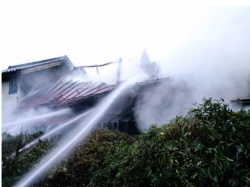
主屋裏側からの放水。棟が落ちたため軒が跳ね上がり、茅の部分が現れたので、そこを集中的に狙っているが、結局茅を掻き出すまでくすぶっていた。
