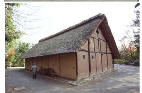
正面・右側面と背面・左側面。正面の屋根が低いのは、下屋が出ているから。
