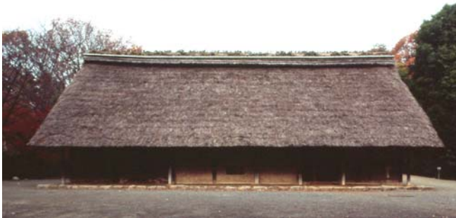
旧廣瀨家住宅の正面。屋根の葺き下ろしが低く、その分屋根が大きくみえます。
