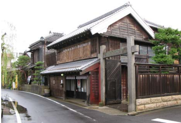
正上醤油店。地震で屋根の瓦のほとんどが落下する被害がありました。今はこのように修理されました。
