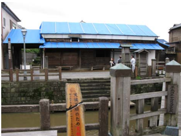
国史跡・伊能忠敬旧宅も被害を受けており、現在建物内の見学はできません。
