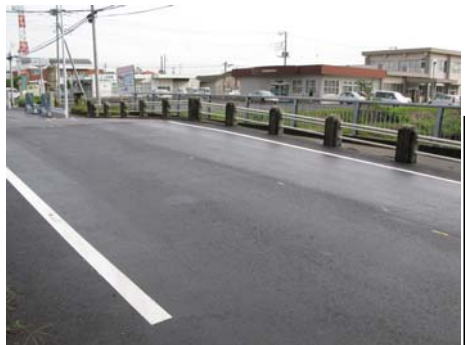
小河川の橋は、川方向に両岸が引っ張られたため、中央が折れています。
