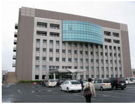
香取市役所庁舎。建物に大きな被害はありませんが、駐車場は液状化で波打っています。
