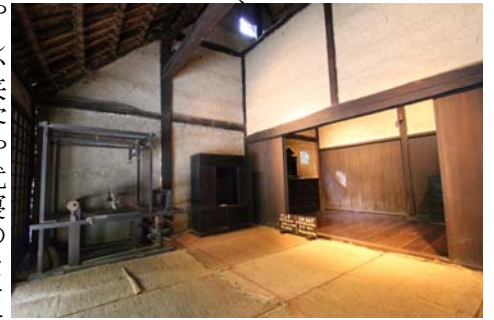
ザシキとナカナンド(奥)。小さな窓が2ヶ所設けられています。
