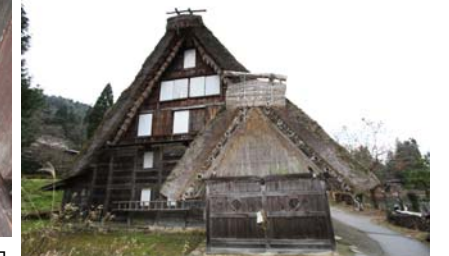
井戸小屋が張りつく妻壁を持つ旧西岡家。
