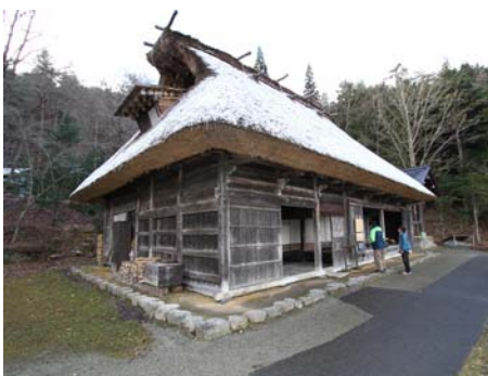
鼻小屋が付く旧八月一日（ほずみ）家。莊川式と呼ばれる寄棟の合掌形式だそうです。
