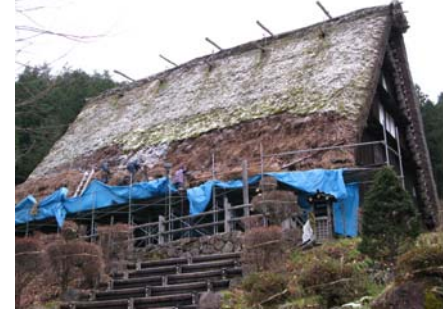
同上。屋根が大きくて大変です。
