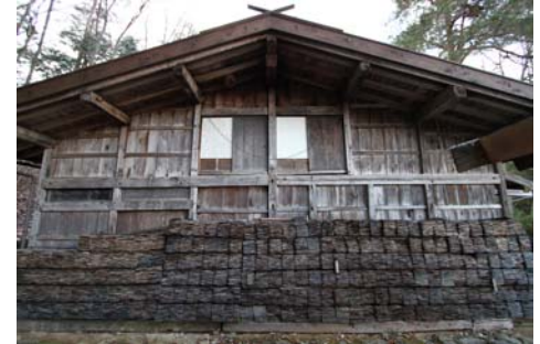
妻壁には次の屋根替用にくれが積みれています。
