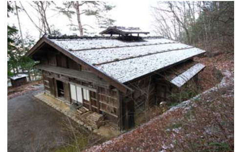
旧新井家住宅。江戸末期のくれ葺き民家。
