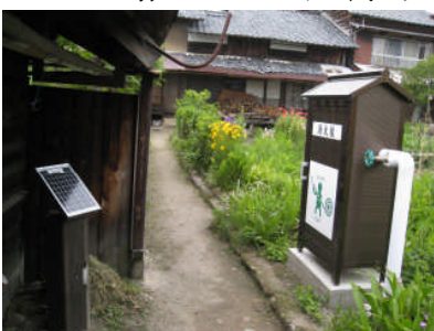
消火栓設置の例。岐阜県恵那市岩村。
