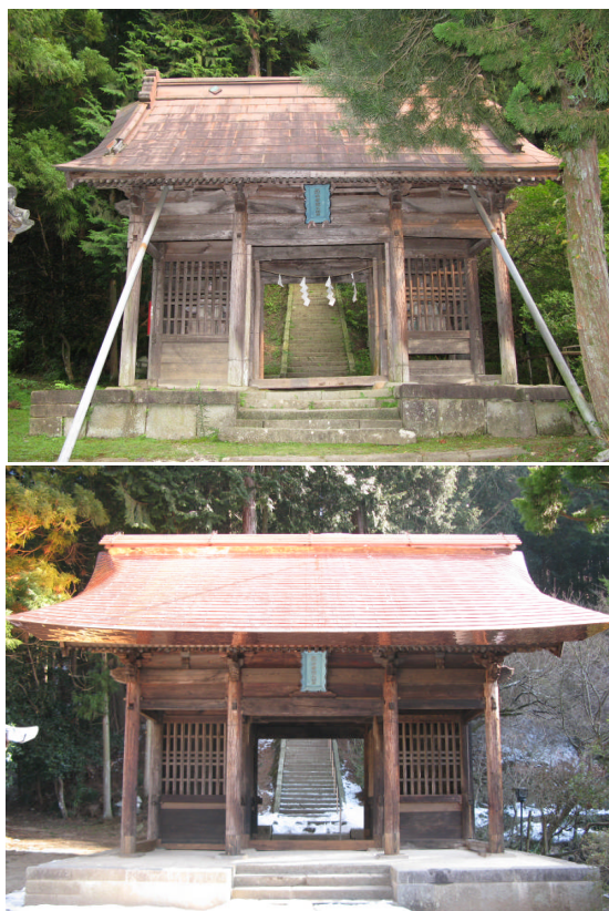
修理前(上)と修理後(下)の比較。
