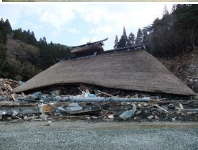
震災前の尾形家住宅(上)と、津波で被害を受けた様子。屋根より下の柱はほぼ全て折れるなどしています。
