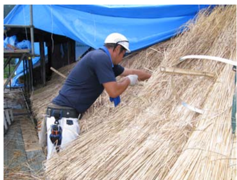
6.職人による茅葺き作業(8月21日)
