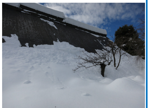
5.主屋の裏側。屋根の雪が全て落ちています。
