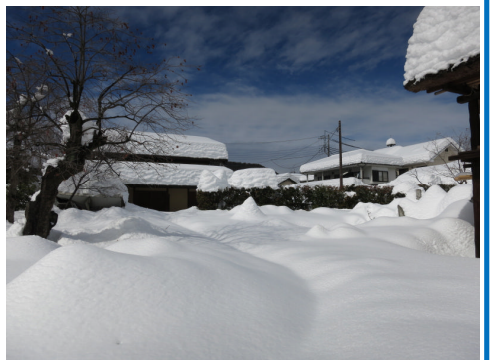
4.主屋の北側。職員の出入口があります。
