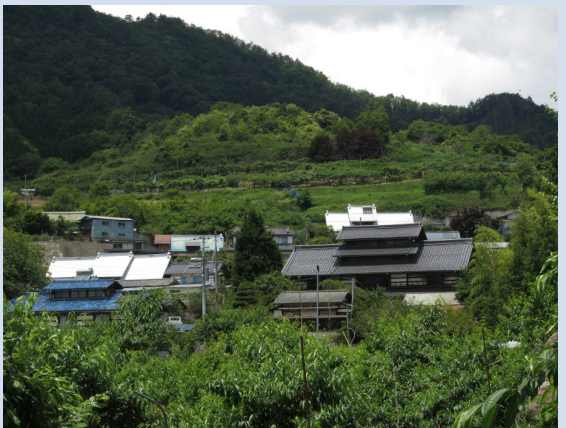
田ノ入からみた民家群。
