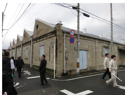
大谷石造のノコギリ屋根工場。
