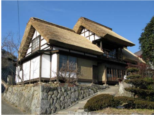
完成した「甲州民家情報館」。玄関左手の壁は荒壁のままです。
