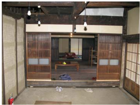
土間と上がりはな 建具は千本格子で、風情があります。壁は荒壁のままです。
