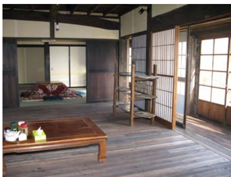
広間 縁側との境にはアルミサッシを入れ、断熱農家を高めています。
