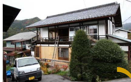
写真1 工事中 (アルミサッシを木製建具に取替え)
