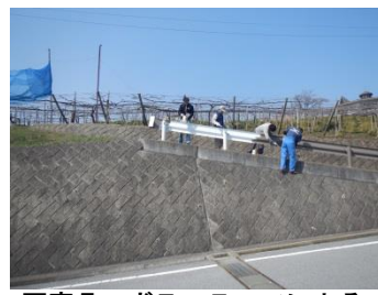
写真5 ボランティアによるガードレールの塗り替え作業
