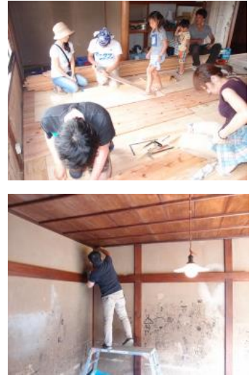
写真3 ボランティアによる改修作業
