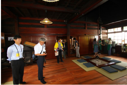
資料館の内観（梁他化粧材に漆が塗られている）
