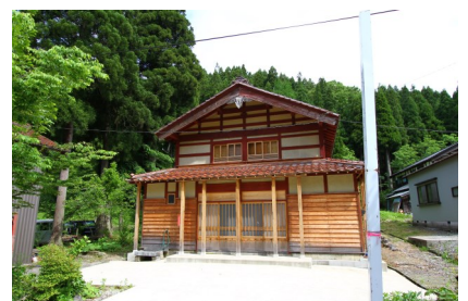
修理された特定物件（主屋）
