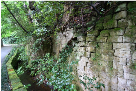
笏谷石が石垣の他、擁壁などに使用されている
