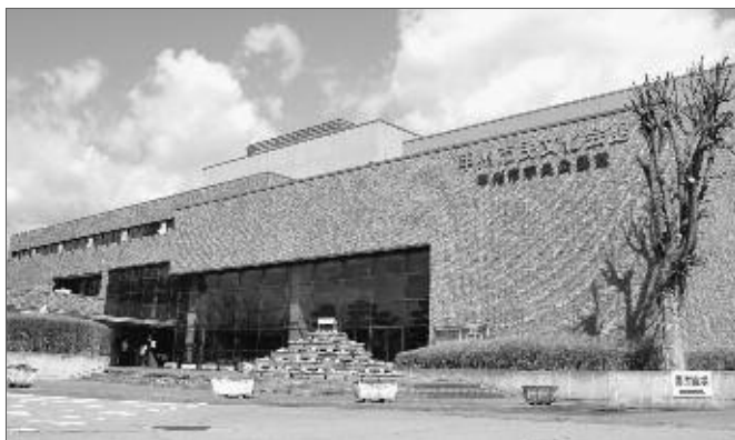
リニューアル事業を行う 甲州市民文化会館。
