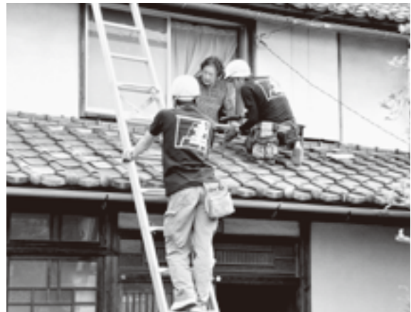
手際よく修繕の奉仕活動する組合員
