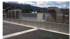
非常用自家発電機
