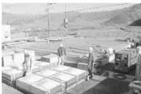
琴川ダムを水源とする、水道用水供給事業の配水池新設工事。(勝沼町下岩崎地内)
