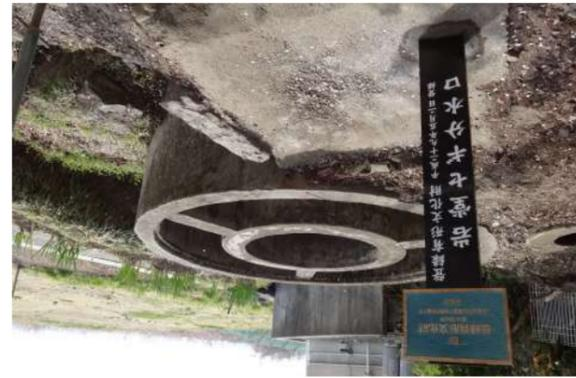
岩堂七分水はJR中央線の鉄橋が川に架かる辺りで取水し、扇状地の「扇の要」の位置である岩堂で3方向に分水され、以後それぞれ交わり、扇状地全体を潤しています。3分水するにあたり、昭和2年(1927)にコンクリート製の円筒形の分水口が設置されました。水を均等に3分水する為、中心の小円筒からサイフォン原理で水を湧かせ、その回りの中円筒で水を均し、3つの隔壁付きの外円筒に分けています。【登録有形文化財】
