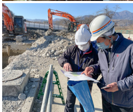
ごみ処理場解体工事の進捗を確認
