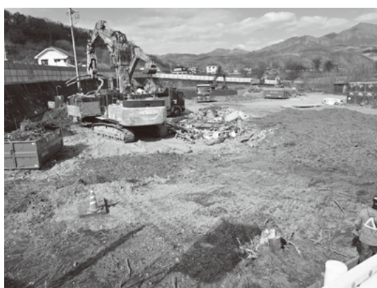
解体工事中の環境センターごみ処理場
