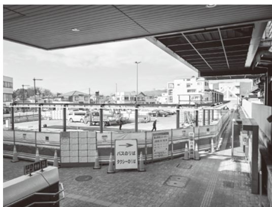
工事中のJR塩山駅周辺
