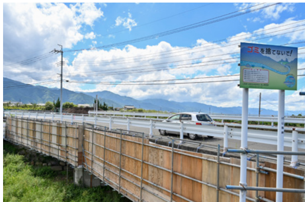
耐震補強等を行っている穴田橋
