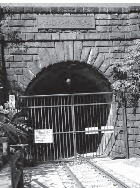
閉鎖中の大日影トンネル遊歩道。来年4月以降の再開に向けて修復工事が実施される
