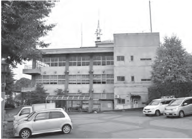
11月以降に実施される市役所旧本庁舎の解体工事。近隣住民等に支障がないよう配慮が求められる
