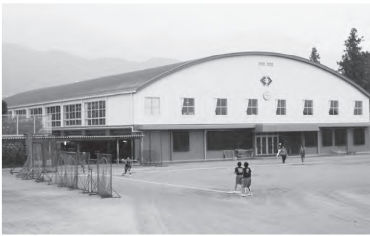
耐震改修工事を行った塩山中学校屋内運動場。改修費は約1億7800万円で大きな事業のひとつとなった
