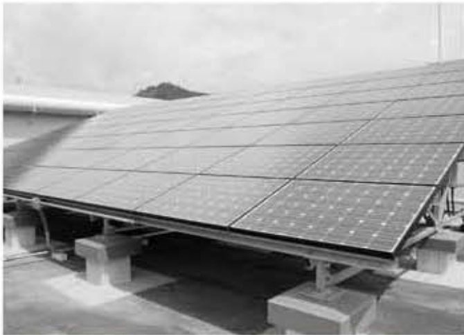
地球温暖化対策のひとつとして、本市でも平成24年度から住宅用太陽光発電システムの設置者に補助金が支給される
