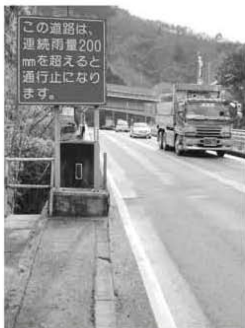
大和町地内を縦断する国道20号は、地元から雨量規制の緩和を求める声が上がっている
