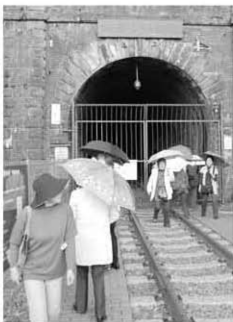
漏水のため緊急閉鎖された大日影トンネル遊歩道は、安全対策を講じた代替コースが設定された
