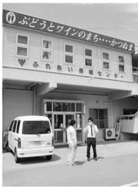
耐震工事などを実施した後、勝沼庁舎として活用される庁舎別館（ふれあい保健センター）
