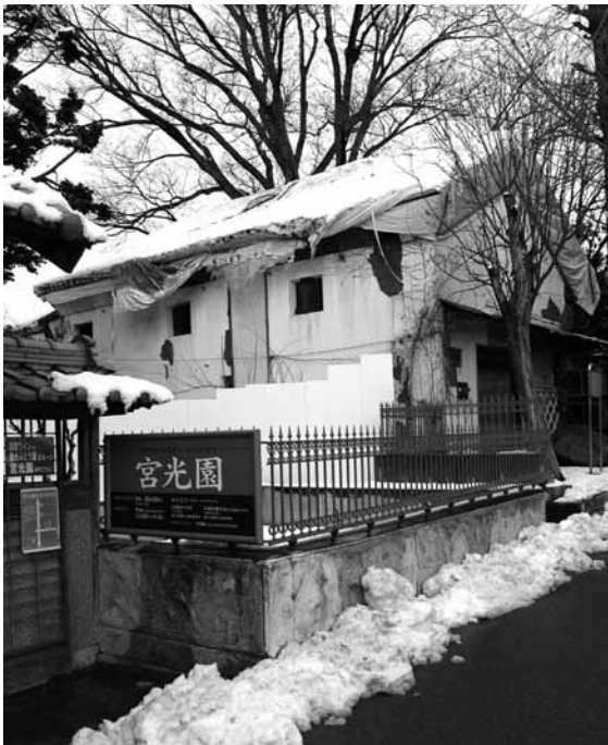
大正時代にワイン蔵として建設された宮光園白蔵。観光交流の拠点施設として活用するため、保存修復工事が実施される
