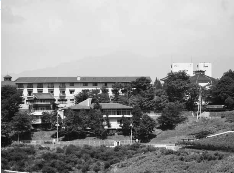
外部委託による特別調査では、過去の経過も含めた詳細な調査が実施され、会計処理、資産管理などの内容に改善すべき事項があると指摘されたぶどうの丘
