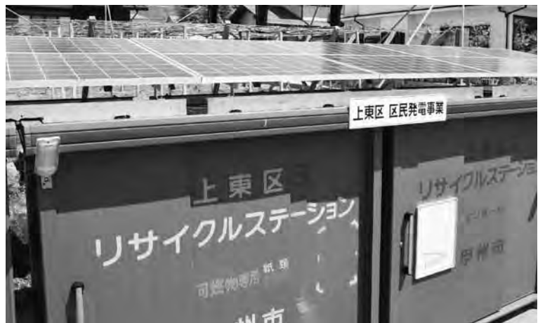
塩山上東区は、市と区の協働事業により、「上東区太陽光発電所」の稼働を始めた
