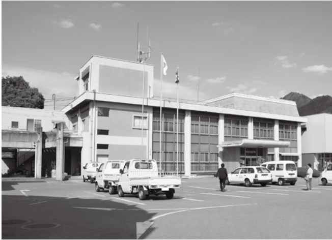
旧勝沼庁舎解体後の跡地や庁舎敷地内の施設は、地域の声を伺う中で有効利用を図っていききたい
