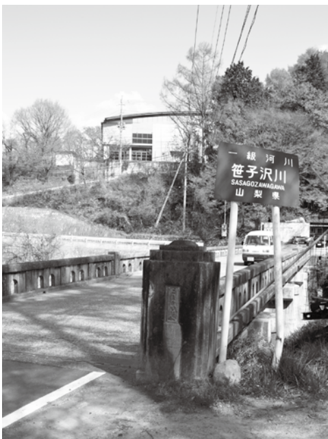
昭和28年の竣工から60年が経過した大和町内の駒飼橋は老朽化が著しく、多くの地元住民から架け替えを要望する声が挙がっている
