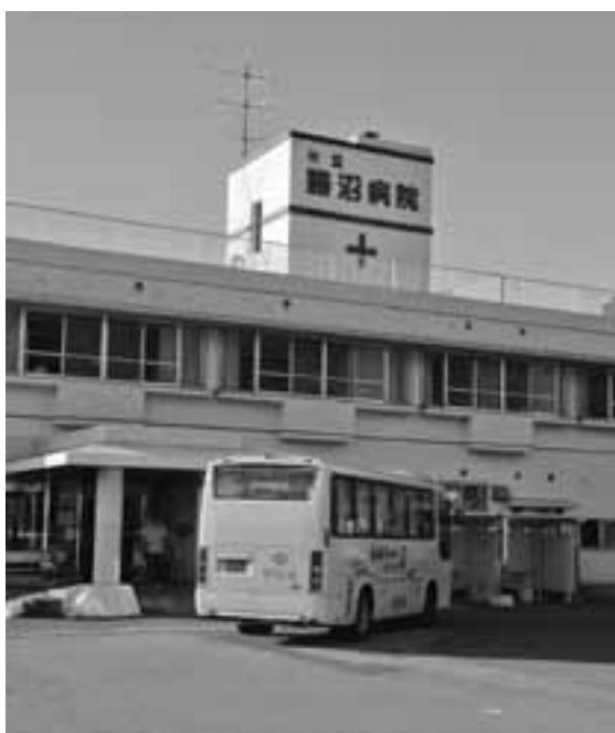
地域医療の拠点施設である勝沼病院。老朽化対策として今後も改修整備が求められる
