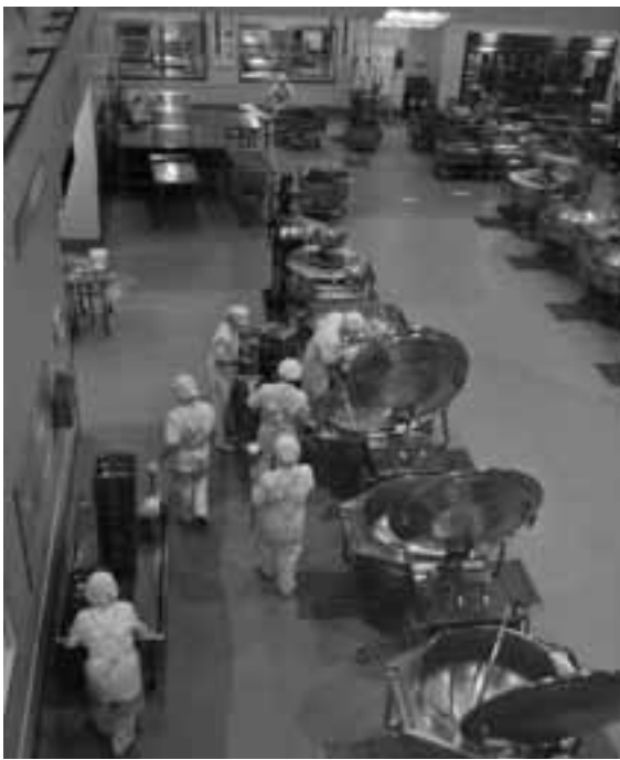
新学校給食センターでは最新の調理システムが導入される（写真は岐阜県可児市の学校給食センター）
