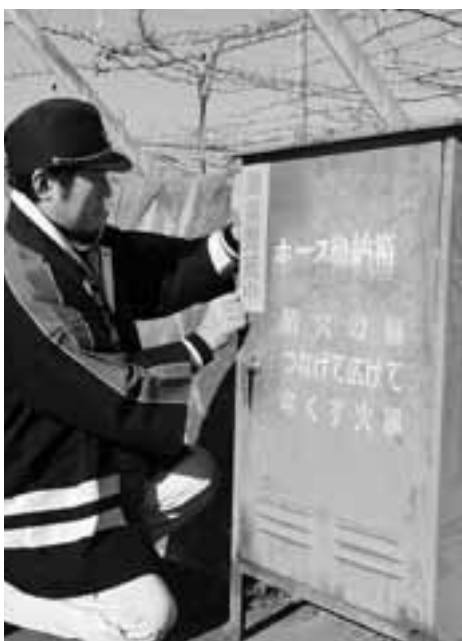
県内各地で消防用品の盗難被害が発生したことから、消火栓ホース格納箱の扉に警告ステッカーを貼り、被害防止対策を講じている
