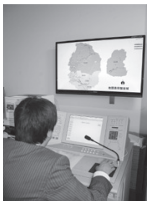
デジタル化の導入に伴い整備された防災行政無線
